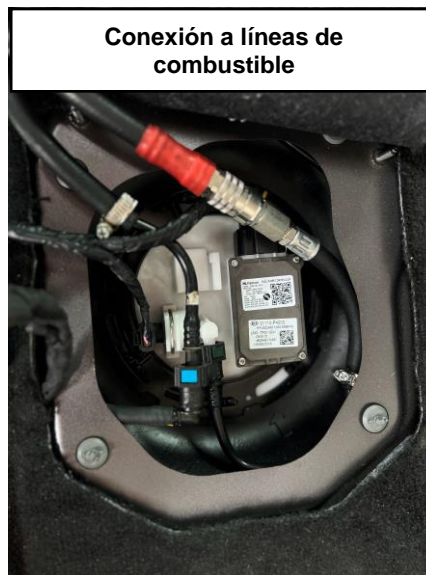
Ilustración 11. Equipo de medición y conexión del equipo a las líneas de combustible.
